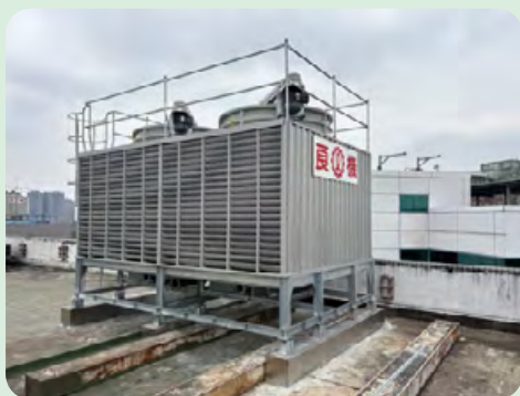
汰換冷卻水塔 (林口總部)
